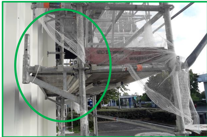
Planchers sur consoles
