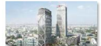
Rénovation de la Tour Pleyel
