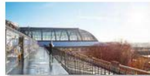
Rénovation du Grand Palais
