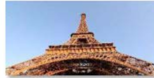
Rénovation Tour Eiffel
