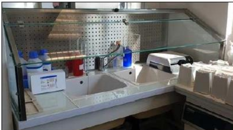
Installation d'un dossier aspirant frontal encoffré à l'arrière de l'évier
