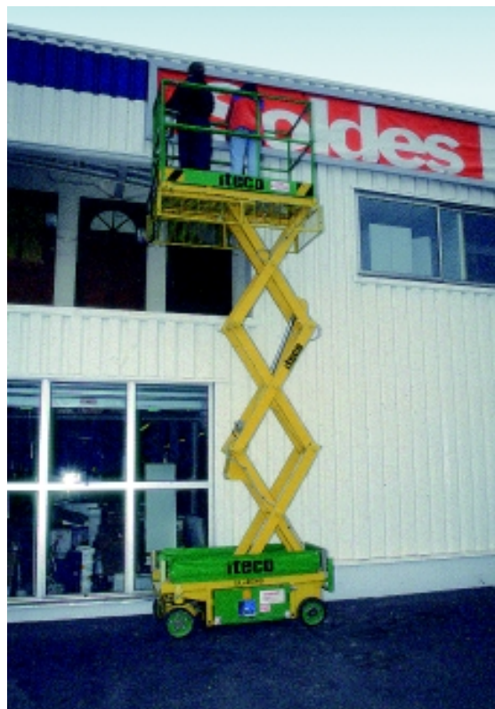
Le travail en hauteur est facilité par la plate-forme élévatrice mobile de personnel.
