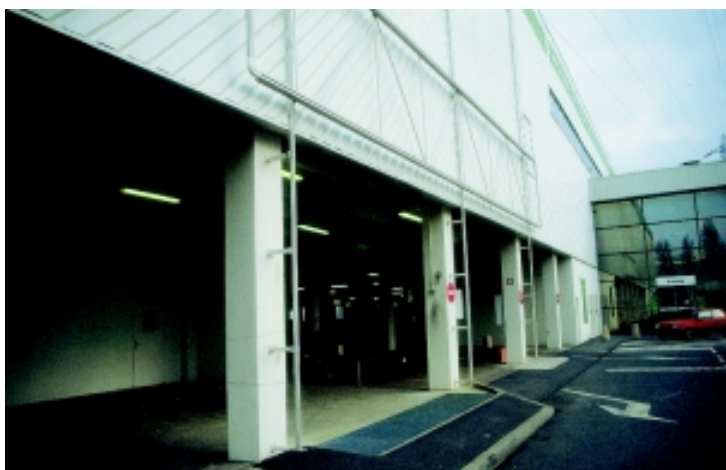
Le support de calicot coulissant permet un travail de plain-pied.
