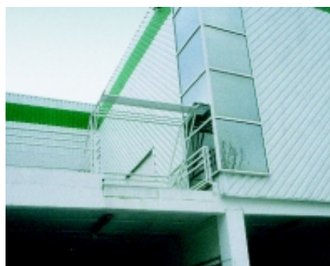
La barrière-écluse permet une réception en toute sécurité.
