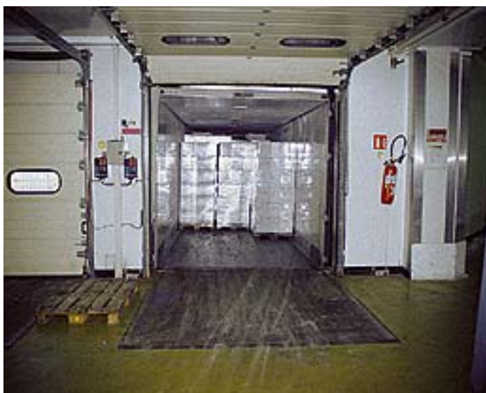
Le pont de liaison permet l'accès des engins de maintenance à l'intérieur du camion.
