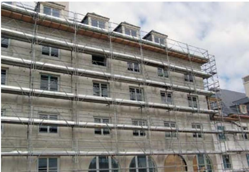
**Mise en place d'un échafaudage de pied** lors de la réhabilitation d'un immeuble de logements de 7 niveaux.
