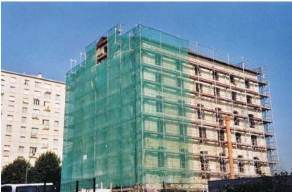
**Mise en place de protections métalliques sur 2 niveaux et demi lors de la construction d'un immeuble de bureaux R + 13 (structure poteaux et poutres en béton).**
