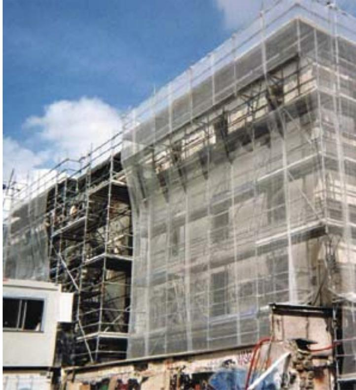
Autre exemple d'utilisation par plusieurs corps d'état d'un échafaudage de pied mis en place lors d'une opération de réhabilitation.
