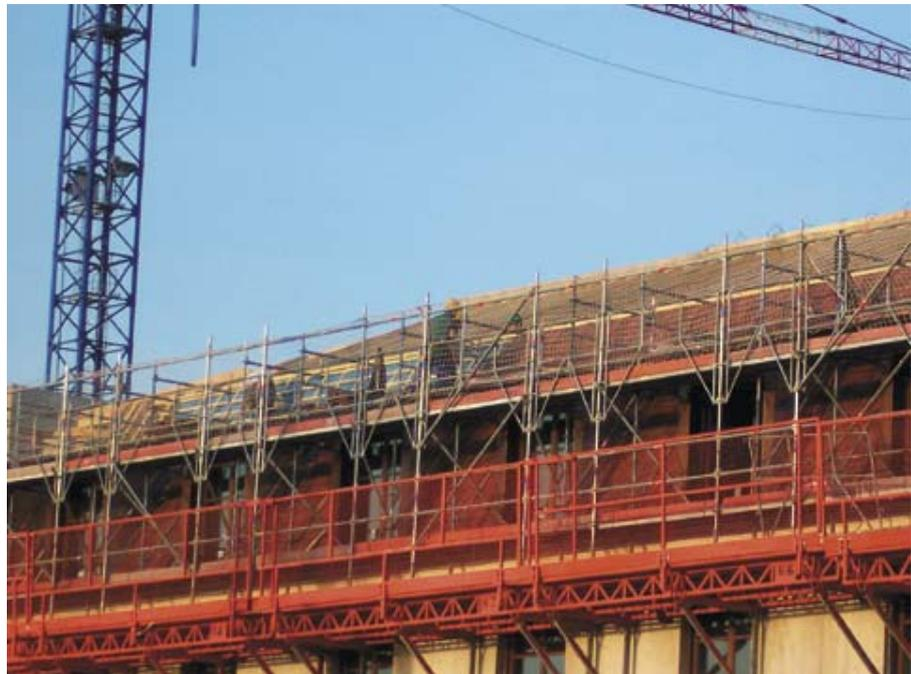
**Mise en place d'un échafaudage de pied** lors d'une opération de construction d'un hôtel.
