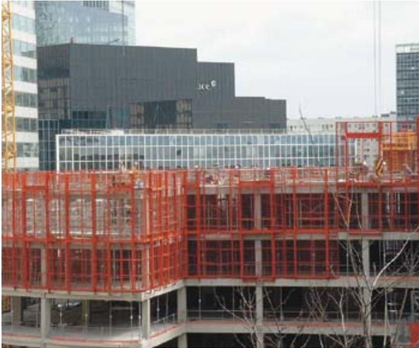
Les outils assurent la protection des salariés effectuant le coffrage, le ferrailage, le bétonnage et le décoffrage des éléments verticaux ainsi que de ceux réalisant la mise en place des étais, la pose des poutres préfabriquées en béton et des dalles alvéolaires, le clavetage des éléments horizontaux et l'enlèvement des étais.
