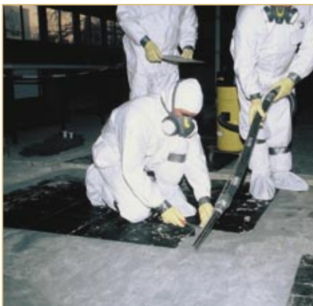
Retrait dalles amiantées
