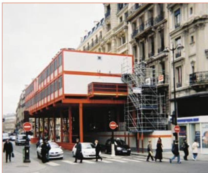
Installations à plusieurs niveaux
