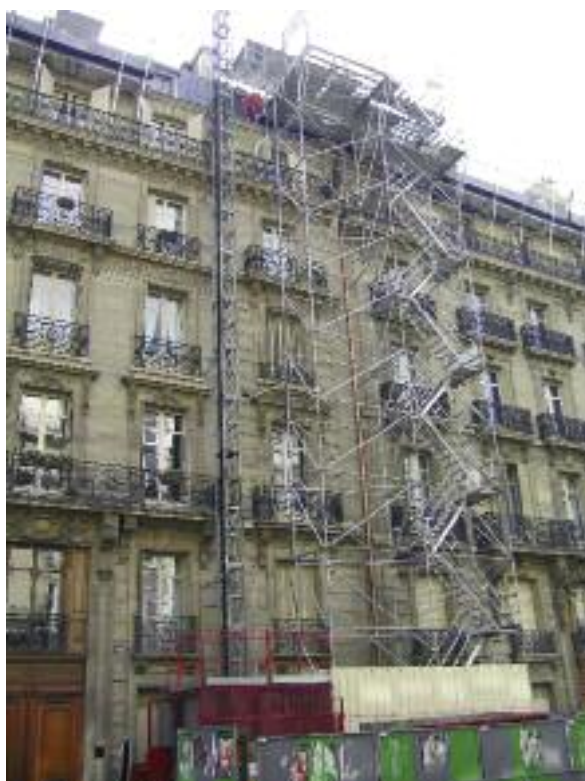
Fig. 33 – Monte-matériaux permettant d'approvisionner le chantier en toiture, complété par une tour escalier
