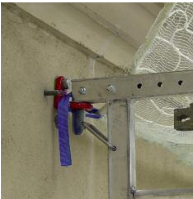
Fig. 4 – Fixation d'une console
