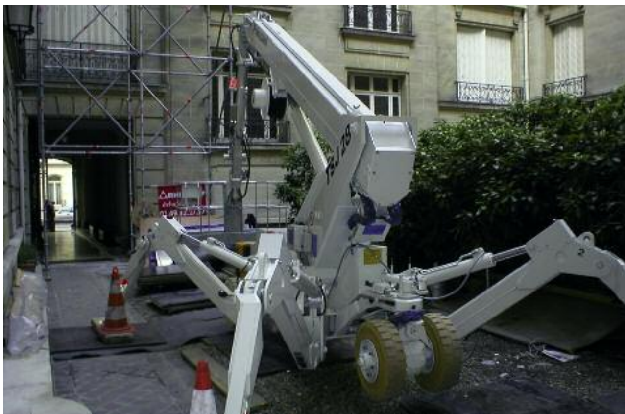
Fig. 24 – PEMP installée dans une courette
