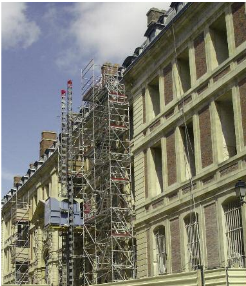
Fig. 32 – Monte-matériaux en façade
