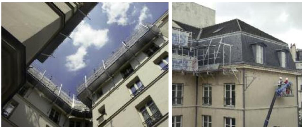
Fig. 19, 20 – Consoles métalliques mises en place à l'aide d'une PEMP
