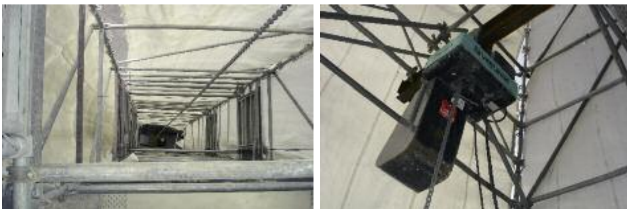
Fig 39 – Treuil installé dans une sapine
