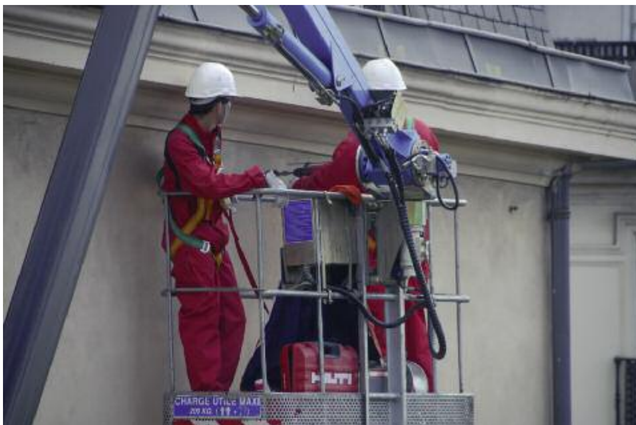
Fig. 25 – Pose des ancrages pour les consoles
