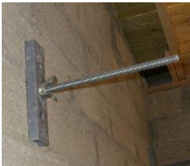
Fig. 1 – Ancrages traversants d'une console d'échafaudage
