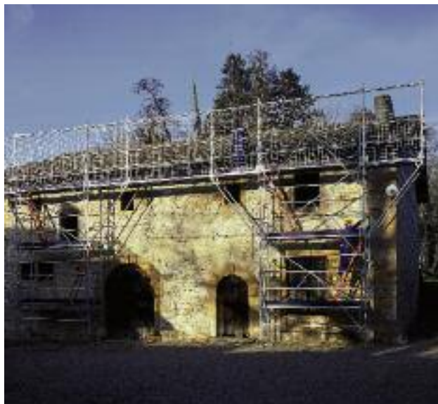
Fig. 10 – Plancher de travail sur sapines avec protection bas de pente ▼
