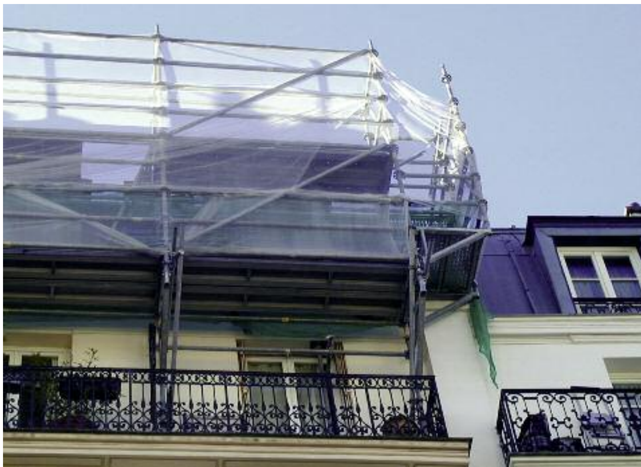
Fig. 11 – Planchers de travail – protection bas de pente - sur échafaudage multidirectionnel avec appuis balkon
