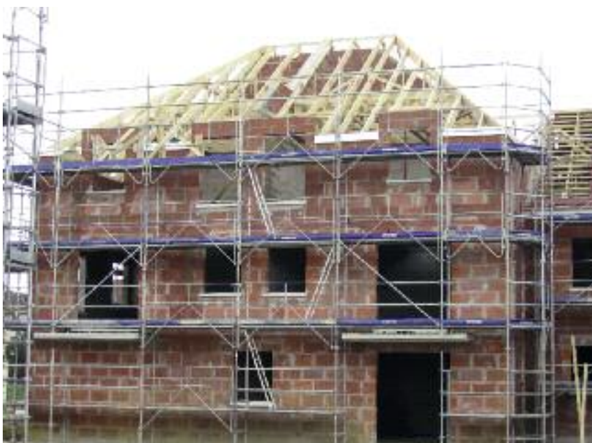
Fig. 8 – Échafaudage MDS servant les travaux de ravalement, de charpente et de couverture
