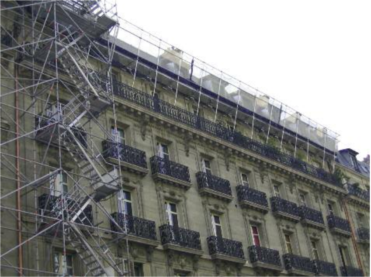
Fig 27 – Échafaudage sur consoles métalliques
