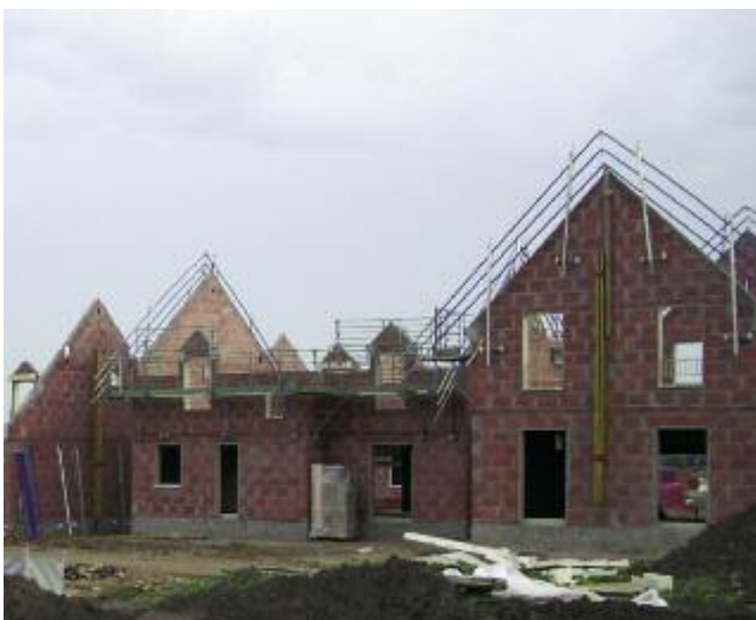
Fig. 6 – Garde-corps en rive de toiture
