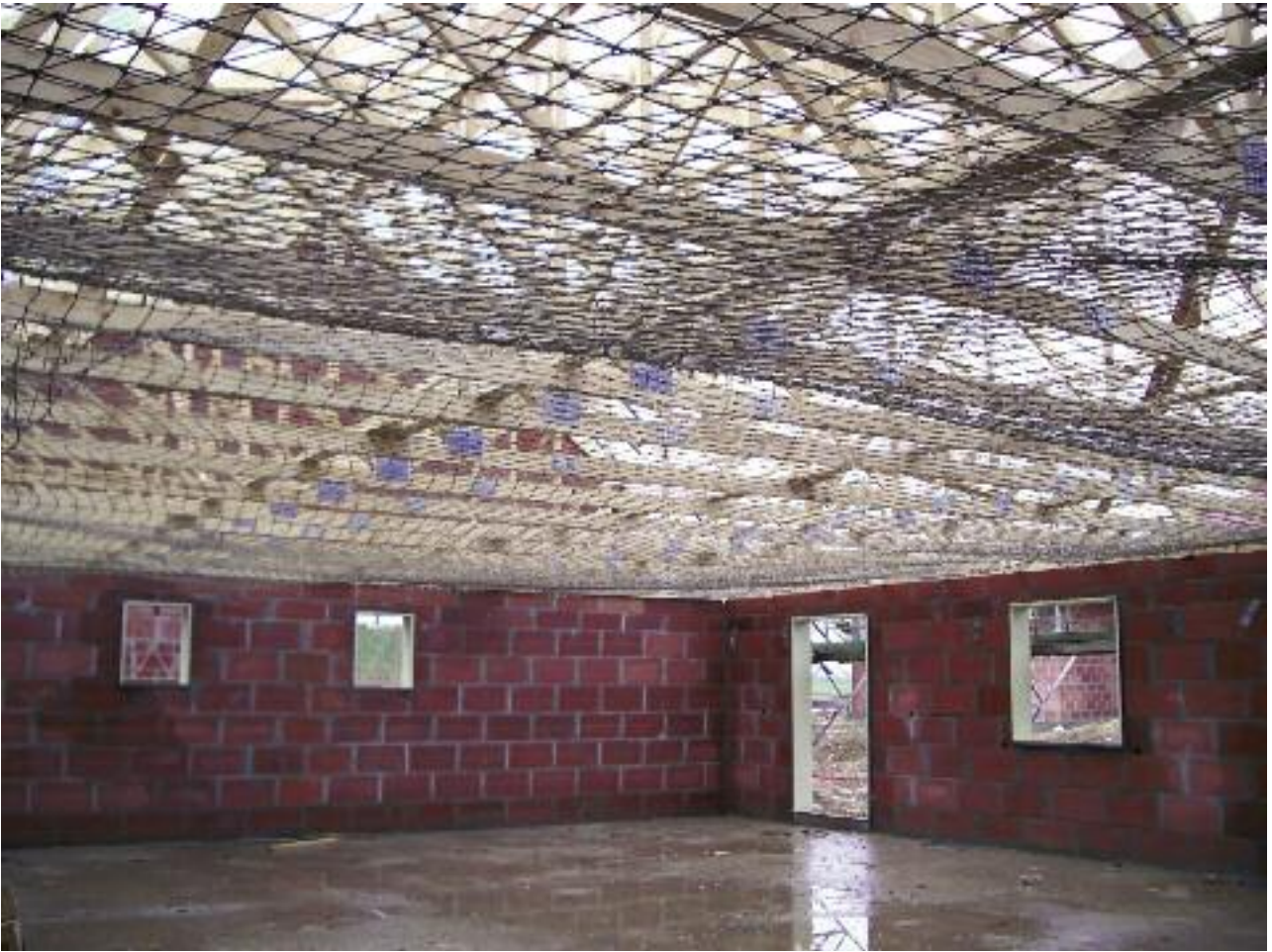
Fig 31 - Filets en sous-face de la charpente
