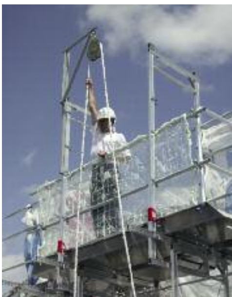
Fig. 40 – Poulie sur potence
