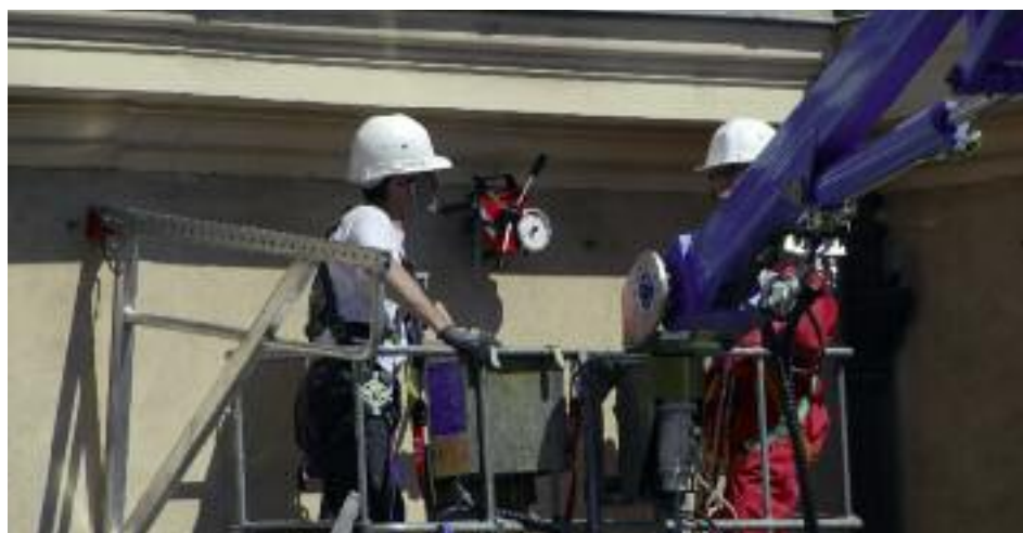
Fig. 2 – Contrôle de la résistance des ancrages sur chantier
