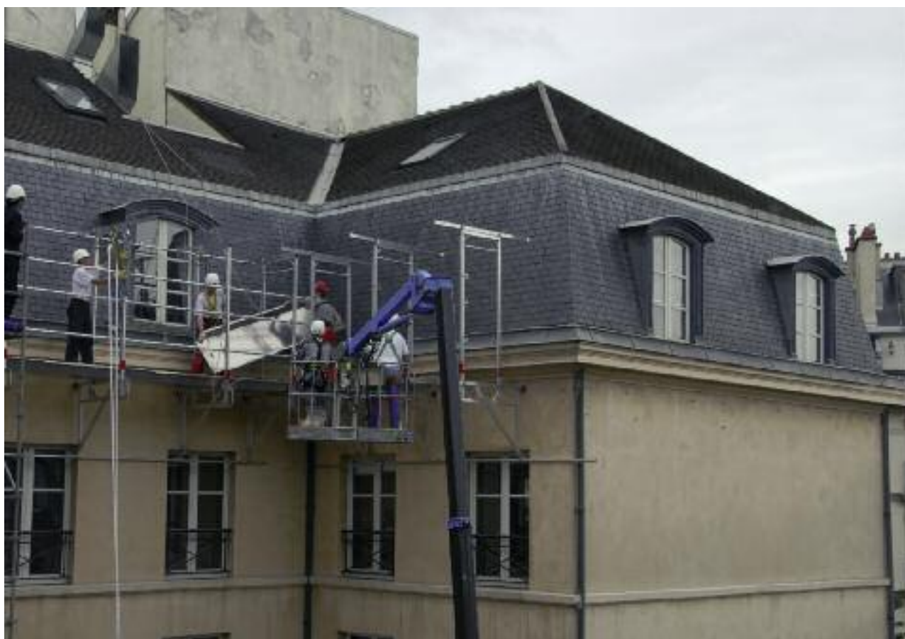
Fig. 26 – Pose de l'échafaudage à l'aide d'une PEMP
