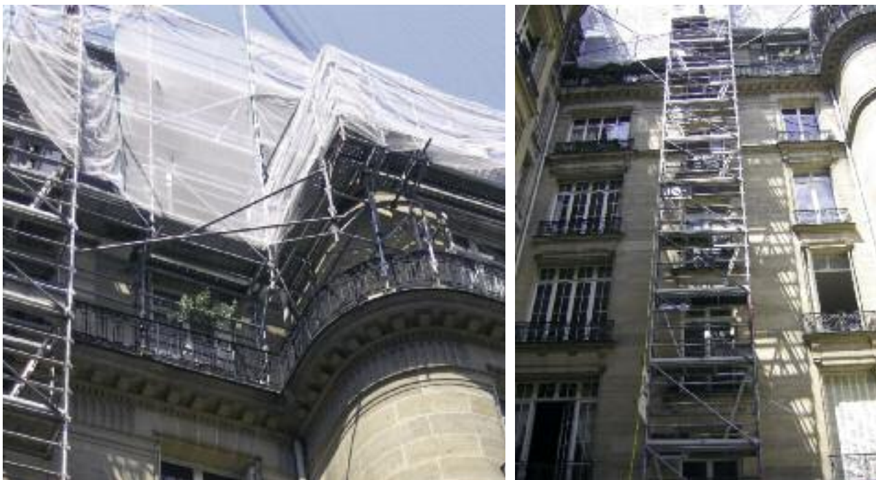
Fig 13, 14 – Plancher de travail sur échafaudage en appui sur balcon et tour d'accès dans courrette
