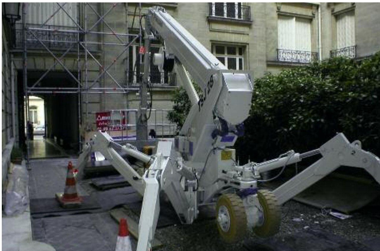
Fig. 24 – PEMP installée dans une courrette
