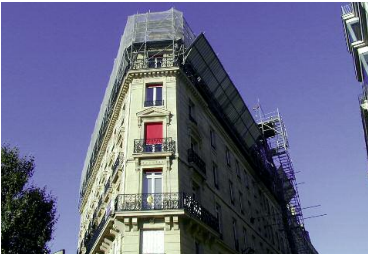
Fig. 12 – Plancher de travail – protection bas de pente – sur échafaudage multidirectionnel prenant appui sur balcons, avec pare-gravats, monte-matériaux et tour d'accès
