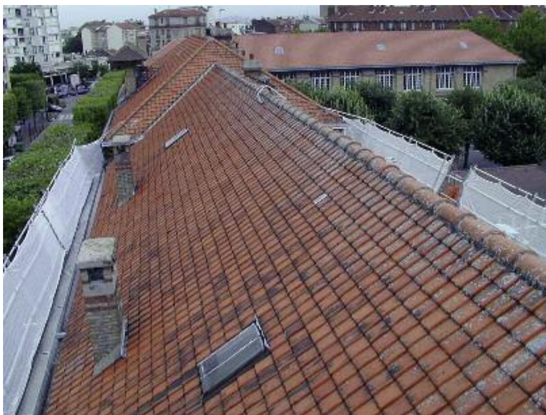
Fig 28 – Protections bas de pente vues du toit
