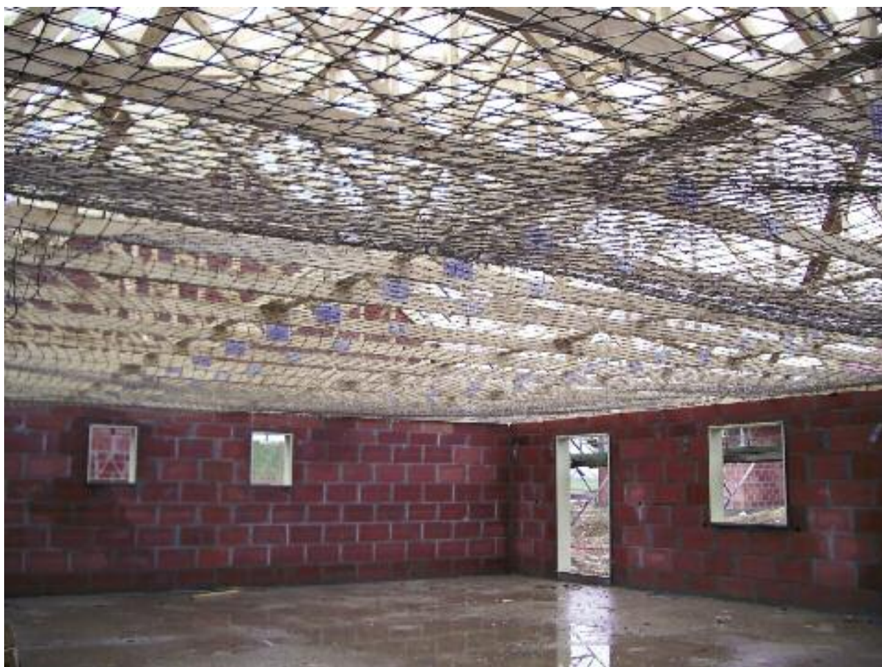
Fig 31 - Filets en sous-face de la charpente
