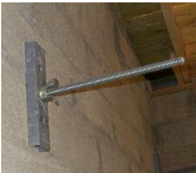
Fig. 1 – Ancrages traversants d'une console d'échafaudage
