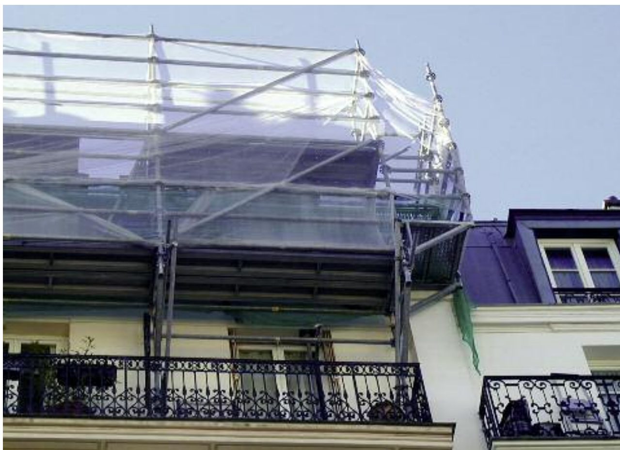
Fig. 11 – Planchers de travail – protection bas de pente - sur échafaudage multidirectionnel avec appuis balcon
