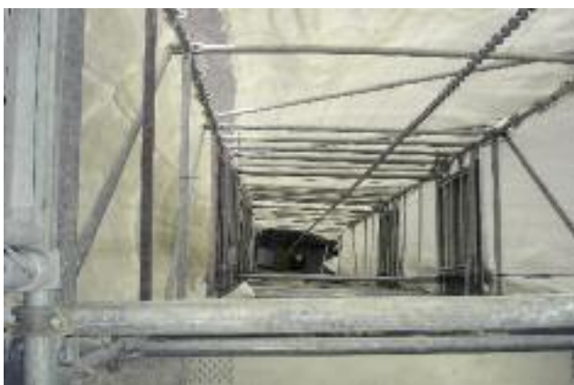
Fig 39 – Treuil installé dans une sapine
