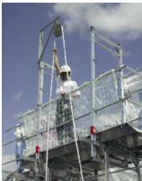
Fig. 40 – Poulie sur potence
