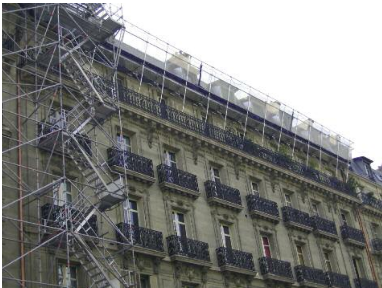
Fig 27 – Échafaudage sur consoles métalliques
