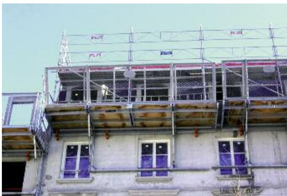
Fig. 16, 17 – PTE en protection de bas de pente pour travaux de couverture
