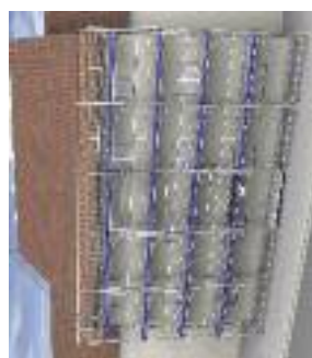
Échafaudage MDS (montage-démontage en sécurité)
