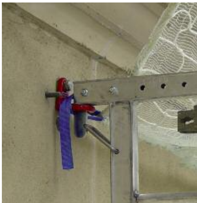
Fig. 4 – Fixation d'une console
