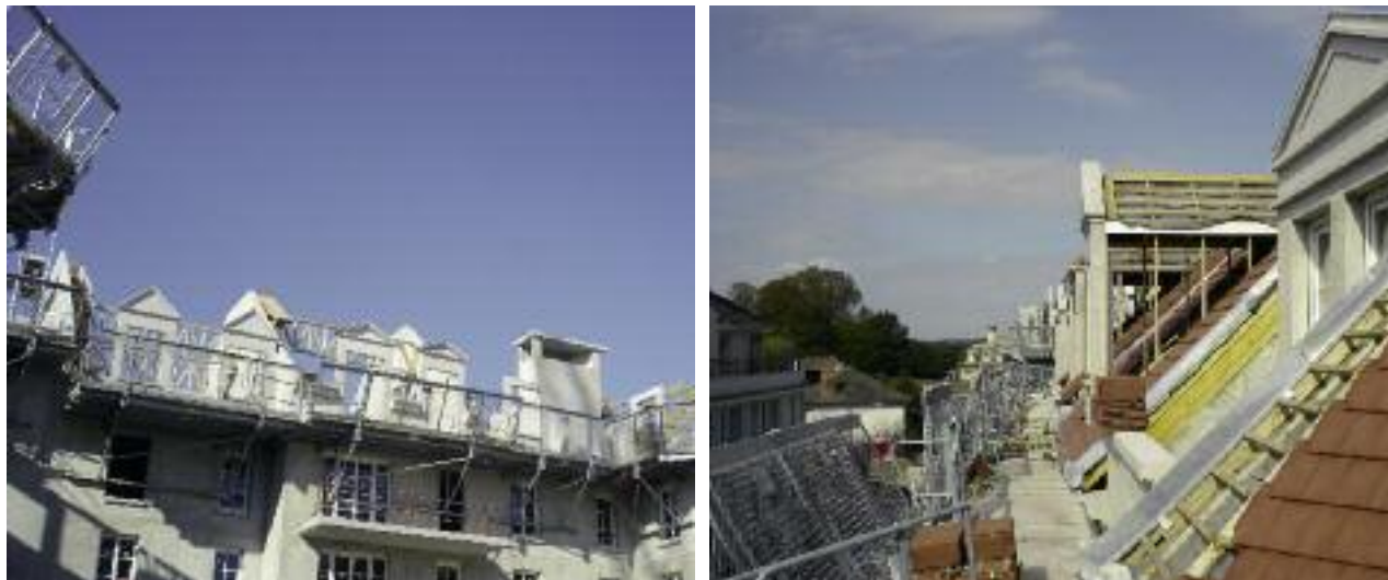
Fig. 16, 17 – PTE en protection de bas de pente pour travaux de couverture
