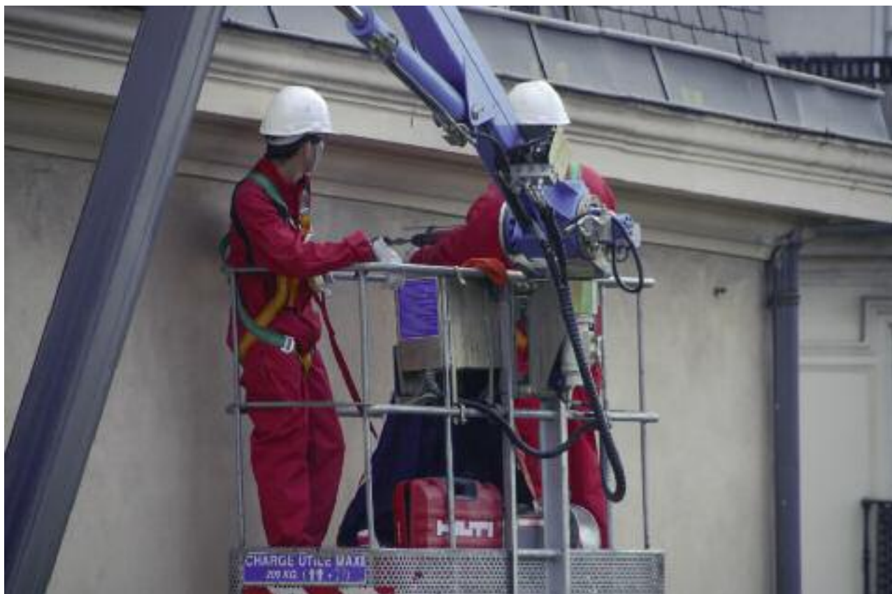
Fig. 25 – Pose des ancrages pour les consoles
