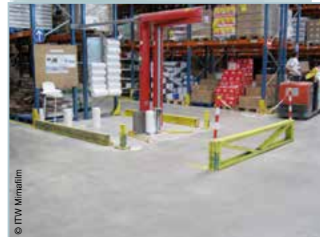
Aménagement d'une aire de filmage sur l'emplacement d'un palettier
