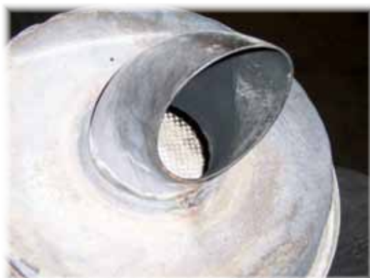
Vue des taches noires avant démontage
