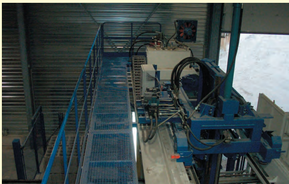
Plate-forme pour interventions sur pince de palettisation
