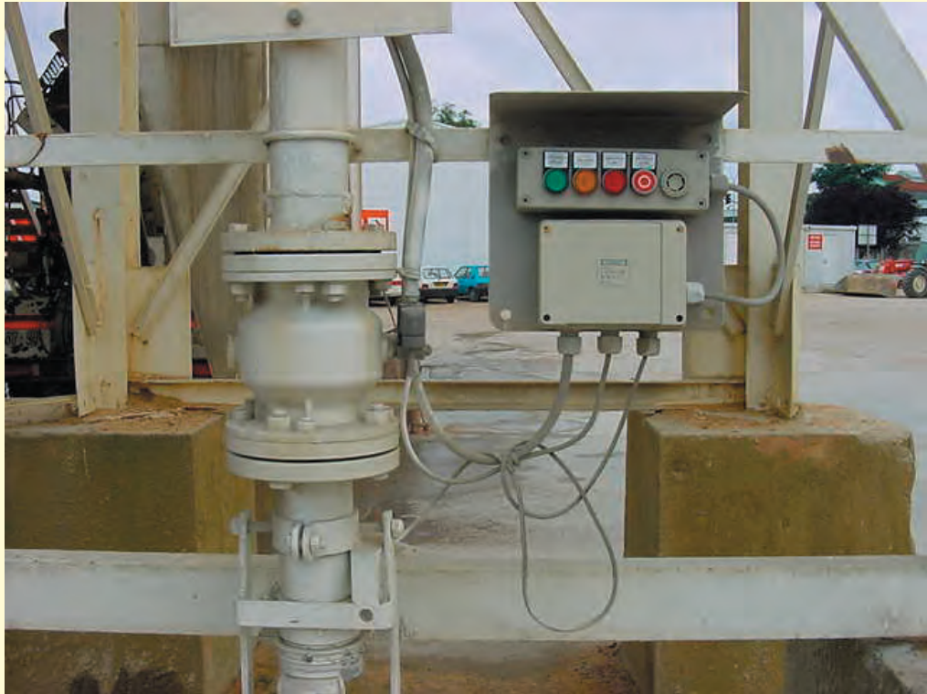
Système de verrouillage des colonnes d'alimentation des silos à ciment par vanne à manchon
