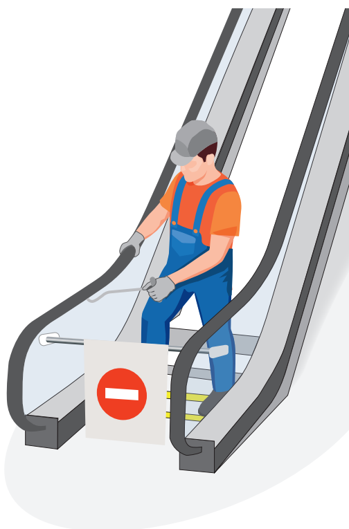
Crochet pour main courante.
